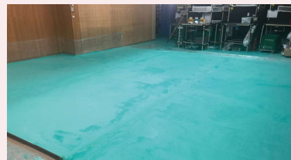
レベリング材打設後 着色したレベリング材の打設 色は10色(標準)
