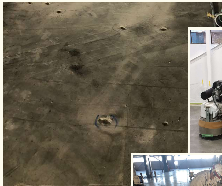
改修前の床 このような床が蘇ります
