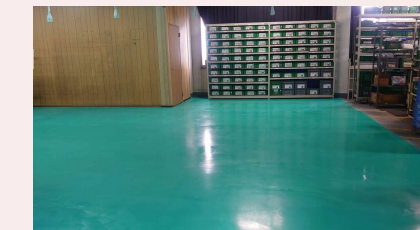
ルミシール塗布 紫外線劣化を防止する為 ルミシールを塗布します
