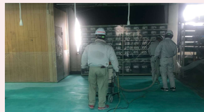
研磨 ポリッシャーによる研磨により #600番程度に仕上げます
