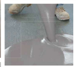
学校の床改修に
