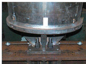
支承板柱脚 (鋼管柱や内装時に適用)
