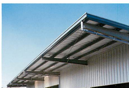
鉄骨現わし大庇
