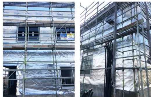
一般住宅／壁面
