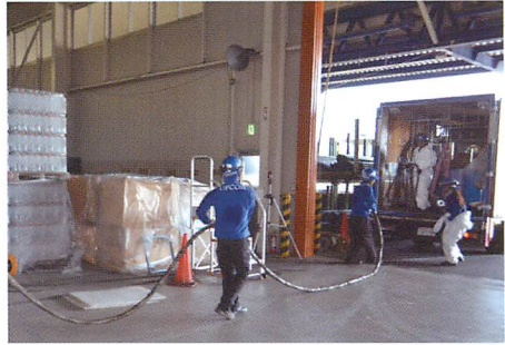
ウレタン樹脂注入用ホース搬入（最大延長80m）
