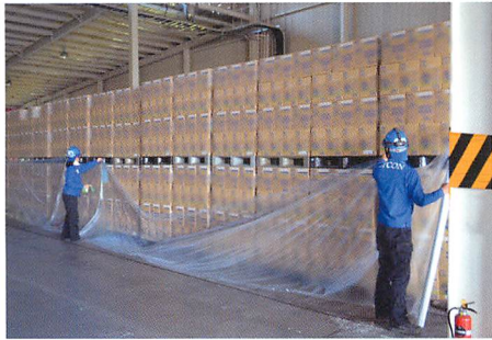
荷物を移動させずに施工（養生徹底）
