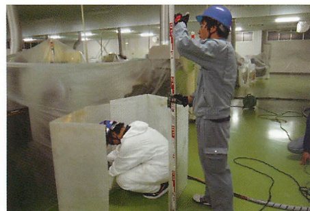
注入の様子（機械を移動させずに作業）
