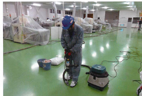
削孔の様子（集塵機を使用し削孔します）
