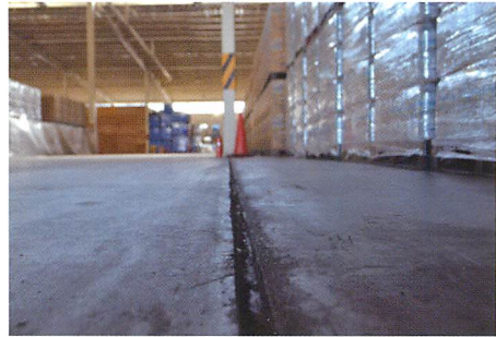
段差が修正され、フラットな状態に
