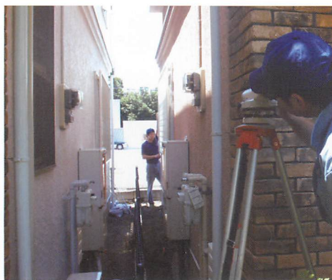
レベル確認をしながらの作業
