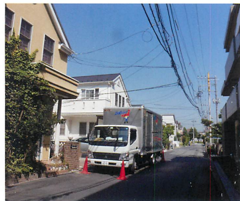
施工プラント車配置
