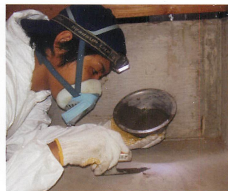
穴埋め(無収縮モルタルを使用)
