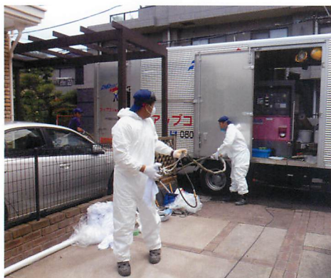
注入ホース延長(最大80m)
