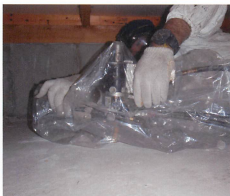
ウレタン樹脂注入作業(床下での作業)
