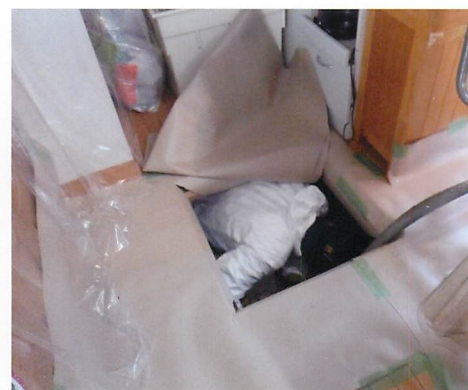
台所床下収納庫より床下へ侵入
