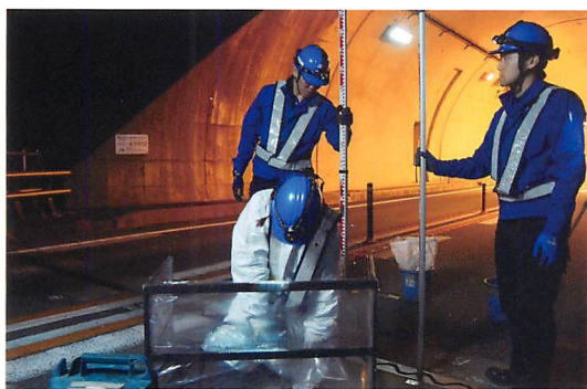
コンクリート舗装版下の空隙充填
