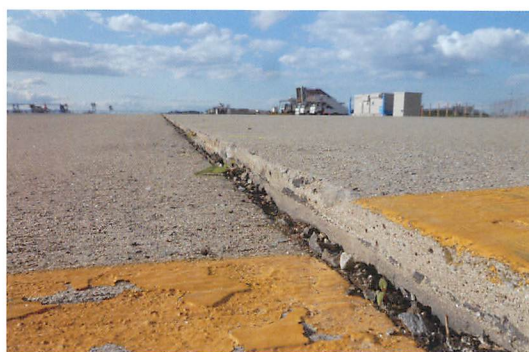
空港エプロンに出来た段差修正
