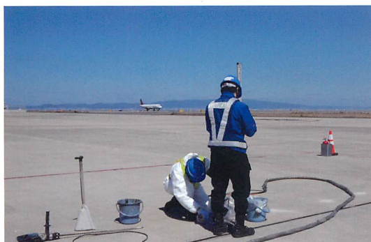
空港の段差修正
