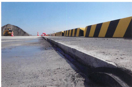
地盤沈下によって水勾配が取れなくなり水溜りが出来た港湾荷降ろし岸壁
