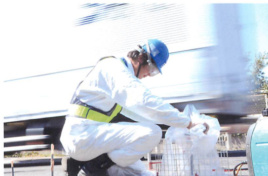
供用を止めない高速道路の空洞充填工事
