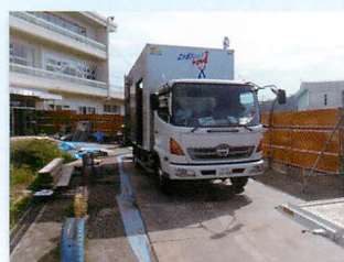
施工プラント車配置 (校舎出入り口)
