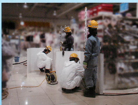
常にレベル確認をしながらの樹脂注入作業 (※複数の施工機械で同時に作業)
