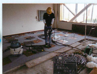
樹脂注入孔の削孔 (集塵機併用)
