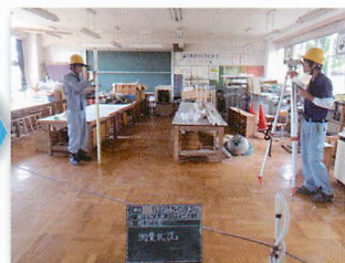
施工後 レベル測量
