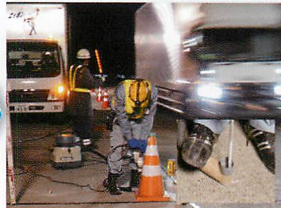
樹脂注入孔の削孔（集塵機併用）
