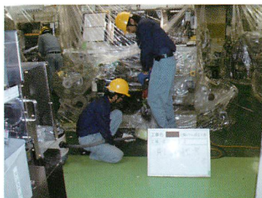
樹脂注入孔の削孔（集塵機併用）
