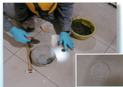
施工後 穴埋め・タイルの復旧
