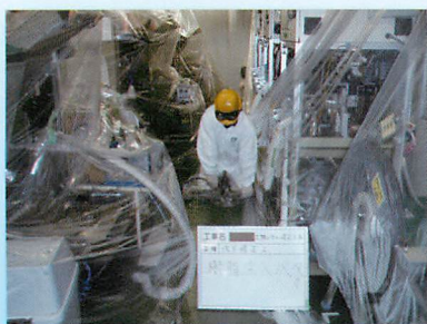
機械そのままの施工(電子部品製造工場)
