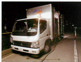
交通規制後、施工プラント車配置
