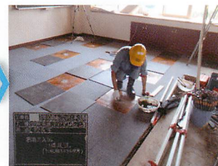
樹脂注入孔の穴埋め
