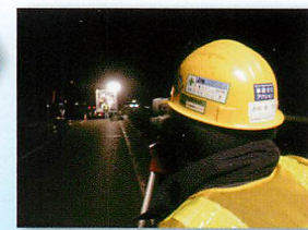
施工後レベル測量
