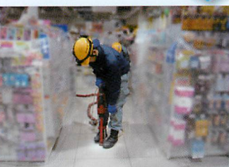
タイル削孔 (コアドリル使用)
