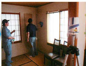
レベル確認をしながらの作業（※作業員 原則5人体制）
