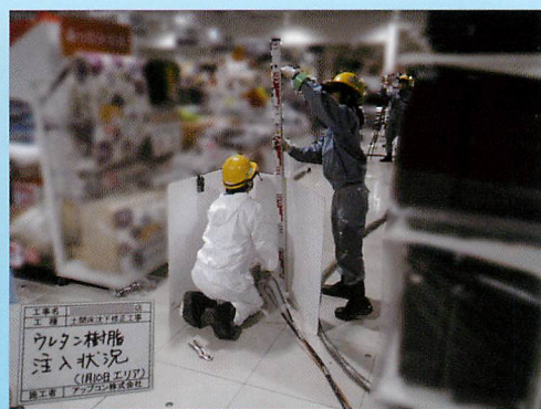
常にレベル確認をしながらの樹脂注入作業 (※複数の施工機械で同時に作業)
