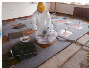
樹脂注入作業
