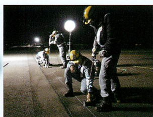
樹脂注入孔の削孔
