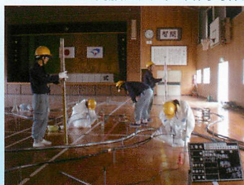
アリーナでの樹脂注入 (2台同時作業)
