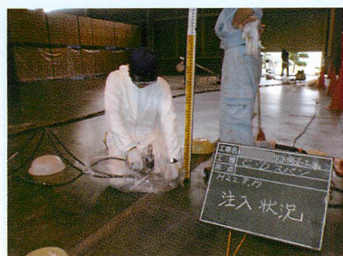
樹脂注入作業
