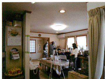
住人が居住しながらの施工
