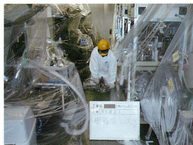
機械を撤去せず沈下修正作業（養生徹底）
