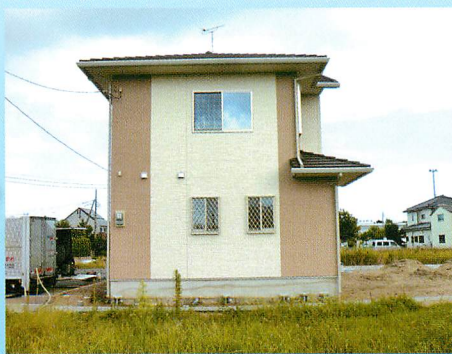
施工後（元のレベルに）
