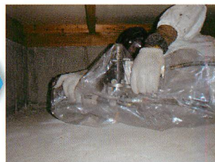
床下での樹脂注入作業（床下高さ500mm）
