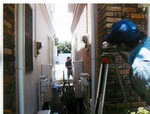
レベル確認をしながらの作業（※作業員 原則5人体制）
