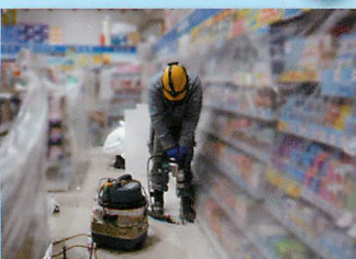
コンクリート削孔 (集塵機併用)
