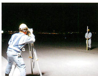
施工後レベル測量
