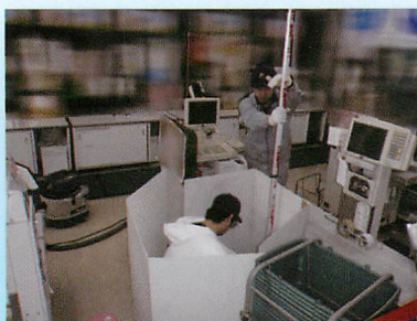
営業閉店中の夜間施工(スーパーマーケット)
