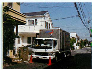
施工プラント車配置（玄関先）
