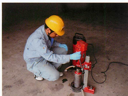
コア抜き作業
