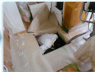
台所床下収納庫より床下に潜る
