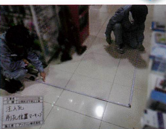
削孔位置マーキング
