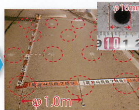
@1.0m千鳥配置の削孔位置
