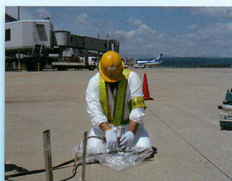
樹脂注入作業
