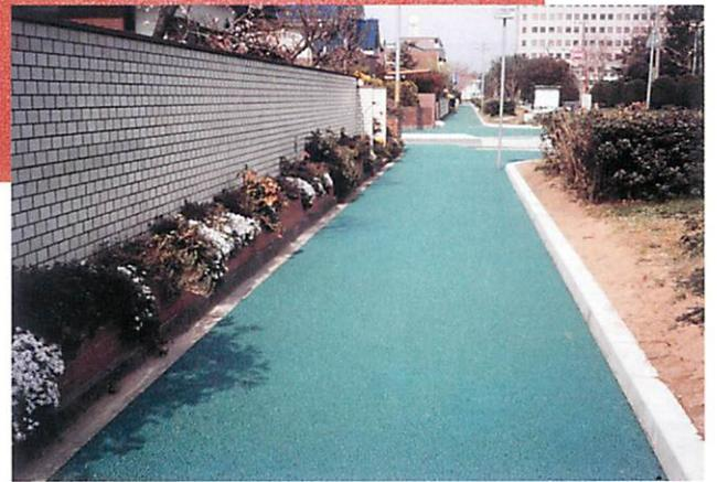
「ポーラスカラー」は、透水性舗装、排水性舗装用に開発された吹付型カラー工法です。舗装の透水能力を減少させることなく、カラフルな塗装に着手できます。景観効果だけでなく、舗装自体の延命や透水能力の経過的維持が期待できます。
