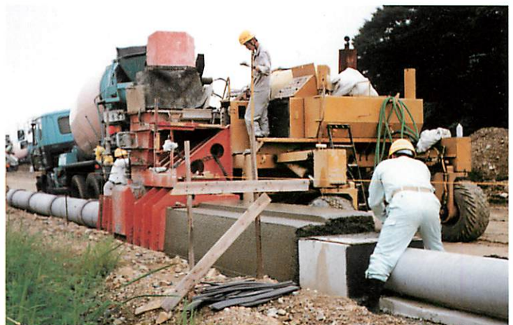
ヒューム管巻き込み施工状況
