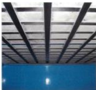
スラブ下補強写真
